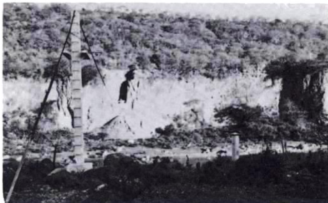
ESTACION "LAS PENITAS II" SOBRE EL RIO ARMERIA TORRE APOYO DEL CABLEVIA EN LA MARGEN DERECHA
