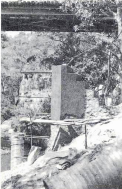
C 3 CONSTRUCCION DE APOYOS PARA LA TORRE DEL LIMNIGRAFO
