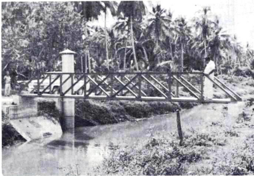
ESTACION " CALLEJONES " CANAL PRINCIPAL MARGEN DERECHA VISTA DEL LIMNIGRAFO, ESCALA Y PUENTE PARA AFOROS
